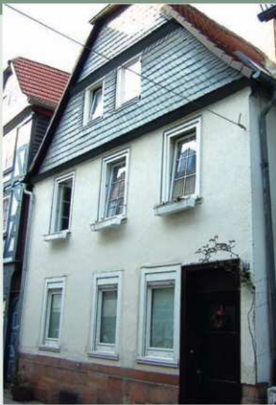
Das Gebäude Weidenhäuser Straße 50 gehört zu den ältesten in Weidenhausen (um 1500 erbaut). Die Hinterhäuser sind erst in der Zeit er-
